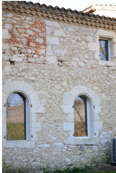
Fig. 14 - Aile intermédiaire, élévation orientale, détail de deux travées.
