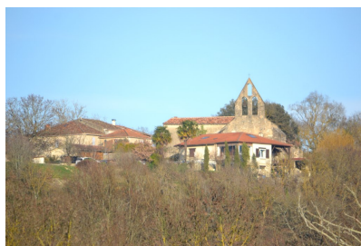
Fig. 2 - Vue d'ensemble depuis l'ouest.
