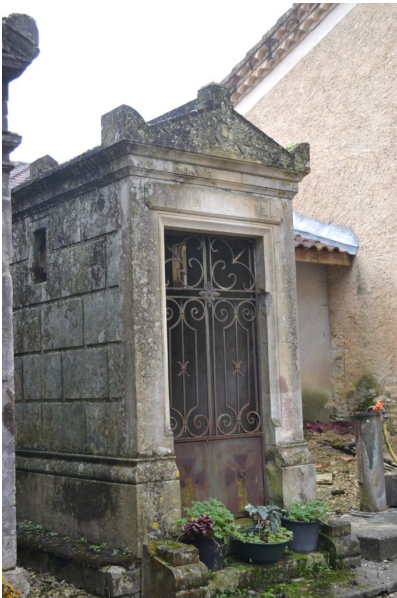
Fig. 28 - Cimetière, caveau près du chevet, vue depuis le nord-est.
