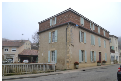
Fig. 8 - Avenue des Thermes, maison (parcelles AX 491-492), vue depuis le sud-ouest.
