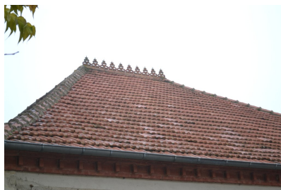
Fig. 5 - Avenue Claude Bordenave, maison (parcelle 104), détail de la crête de toit, vue depuis l'est.
