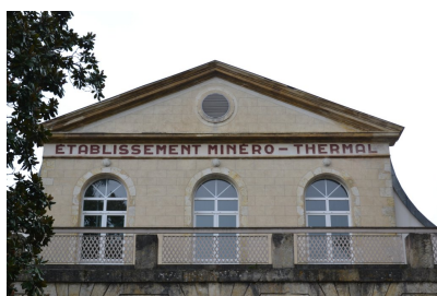
Fig. 5 - Façade nord, détail du fronton portant l'inscription : "ETABLISSEMENT MINERO-THERMAL".
