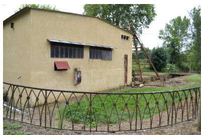
Fig. 5 - Bonas, Le Comté, usine hydroélectrique (AK 11) et écluse, vue depuis le nord-ouest.
