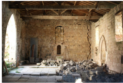
Fig. 20 - Vue intérieure de la nef depuis l'entrée, vue depuis l'ouest.
