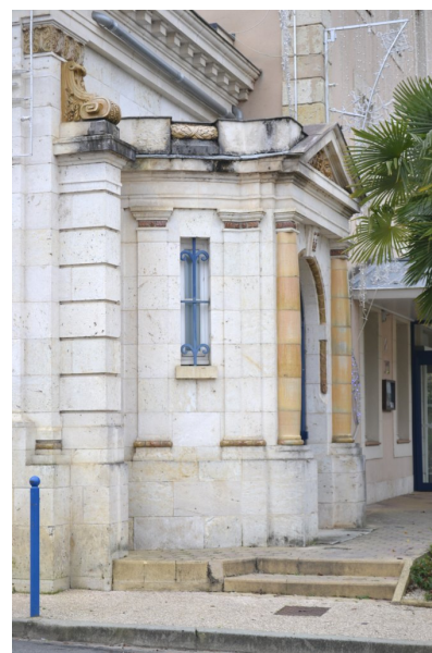
Fig. 9 - Façade nord, galerie du musée, ancienne porte, vue depuis l'est.
