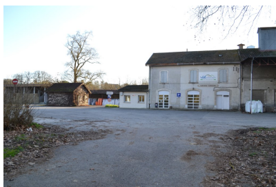
Fig. 1 - Vue d'ensemble depuis le nord.
