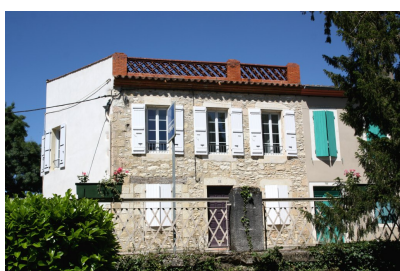
Fig. 10 - Avenue des Thermes, maison (parcelle 111), vue depuis le sud.
