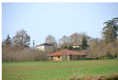
Fig. 2 - Hameau de Bergès, vue d'ensemble depuis le nord-est.
