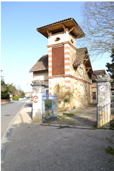
Fig. 28 - Annexes de l'ancienne villa Lannelongue, vue depuis le sud-est.
