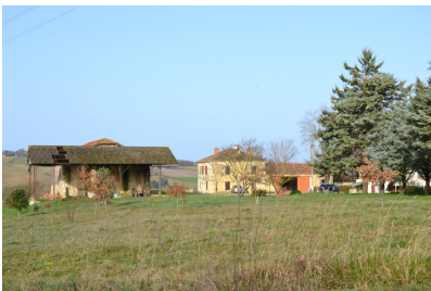
Fig. 16 - Guillauma, vue d'ensemble depuis l'est.
