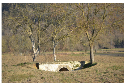
Fig. 7 - Castéra-Verduzan, Belair, ancien pont (sections AW et WR, non cadastré), vue depuis l'ouest.
