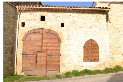
Fig. 12 - Maison (parcelle AS 22), façade sud (après travaux).
