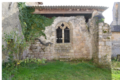
Fig. 11 - Chapelle nord, vue depuis le nord (après travaux).
