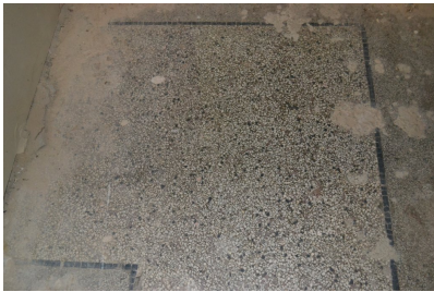
Fig. 43 - 1er étage, partie désaffectée, sol en terrazzo.
