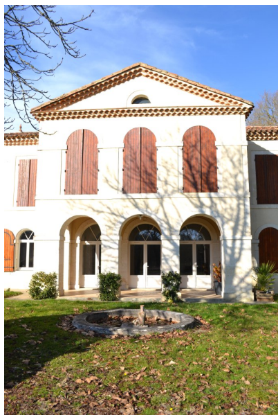
Fig. 4 - Corps de bâtiment principal, façade sud, détail de l'avant-corps central.
