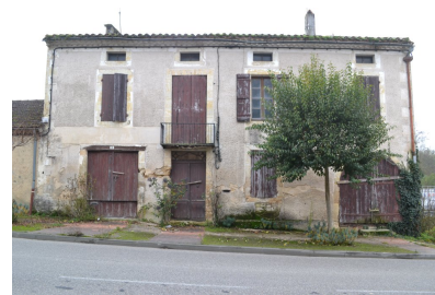
Fig. 6 - Avenue Claude Bordenave, maison (parcelle 105), vue depuis le nord-est.
