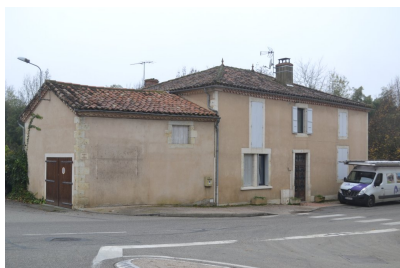
Fig. 7 - Avenue des Thermes, maison (parcelles AX 593-594), vue depuis le nord-est.
