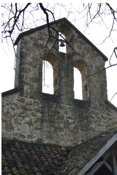
Fig. 4 - Clocher, vue depuis le nord-ouest.
