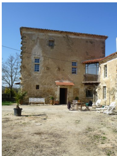
Fig. 2 - Vue de la tour prise de l'Est.
