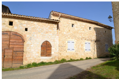
Fig. 11 - Maison (parcelle AS 22), vue depuis le sud (après travaux).
