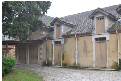
Fig. 14 - Communs, partie sud, vue depuis le nord-est.
