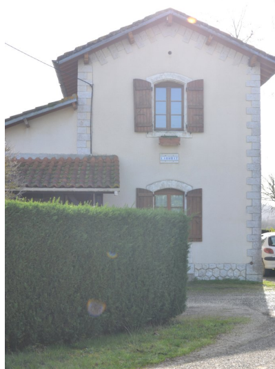
Fig. 11 - Castéra-Verduzan, A Larruat, maison de garde-barrière (parcelles AT 34-35), vue depuis le nord.
