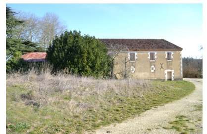
Fig. 51 - Ancienne hôtellerie, vue d'ensemble depuis l'ouest.
