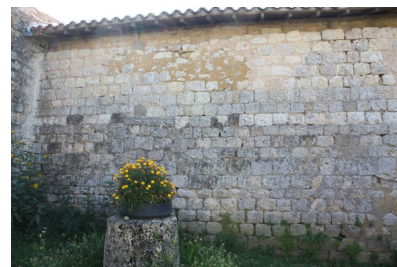
Fig. 12 - Mur nord de la nef, vue depuis le nord.
