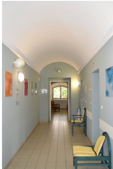
Fig. 38 - 1er étage, couloir oriental, vue depuis le sud.
