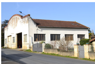
Fig. 1 - Vue d'ensemble depuis le sud-est.
