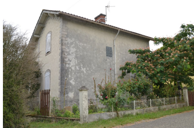
Fig. 2 - Bonas, Berrouy (AN 1), maison de garde-barrière.
