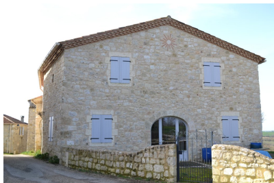
Fig. 10 - Maison (parcelle AS 22), vue depuis l'est (après travaux).
