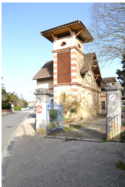
Fig. 1 - Vue d'ensemble depuis le sud-est.
