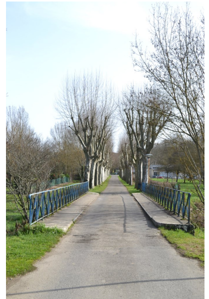
Fig. 12 - Pont de la Promenade de l'Auloue, vue depuis l'ouest.
