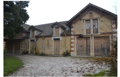
Fig. 12 - Communs, vue depuis le nord-est.
