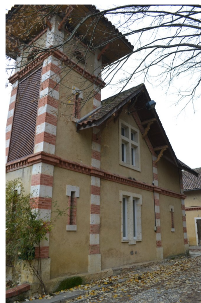
Fig. 6 - Maison de gardien, élévation orientale, vue depuis le sud-est.
