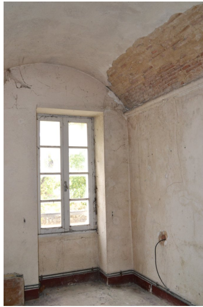
Fig. 41 - 1er étage, partie désaffectée, chambre.
