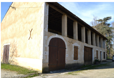
Fig. 49 - Ancienne hôtellerie, vue depuis le sud-est.
