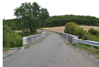
Fig. 3 - Bonas, Laressource, pont, vue depuis le sud.
