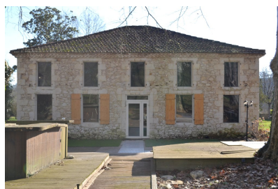
Fig. 17 - Corps de bâtiment secondaire, vue depuis le nord.
