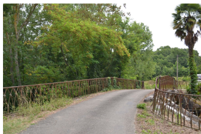
Fig. 8 - Bonas, Le Comté, pont, vue depuis l'ouest.
