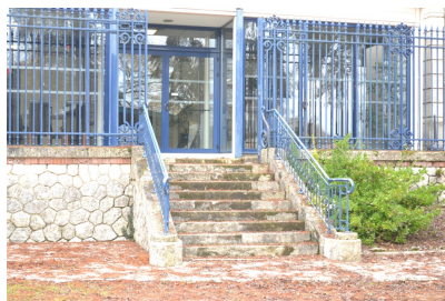
Fig. 23 - Elévation sud donnant sur le parc, détail de l'escalier.
