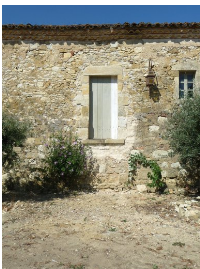
Fig. 4 - Détail d'une dépendance, cour intérieure (mur Sud).
