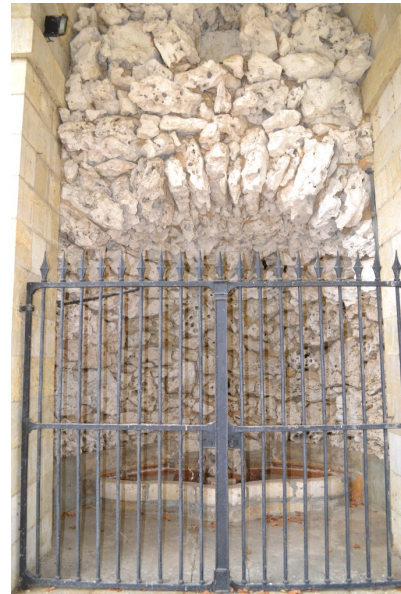
Fig. 9 - Façade nord, portique, fontaine orientale.
