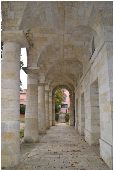
Fig. 13 - Façade nord, portique, vue depuis l'ouest.
