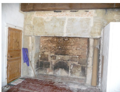
Fig. 4 - Cheminée du deuxième étage de la tour.
