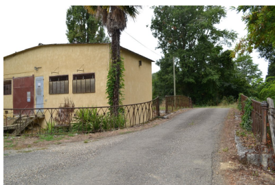
Fig. 4 - Bonas, Le Comté, usine hydroélectrique (AK 11) et pont, vue depuis l'est.
