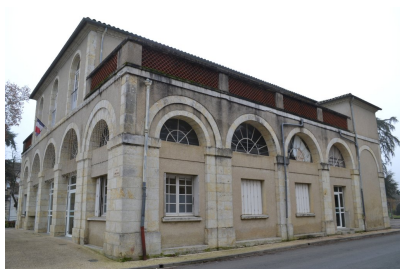
Fig. 4 - Vue depuis le nord-ouest.
