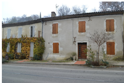
Fig. 2 - Avenue Claude Bordenave, maisons (parcelles AX 86, 87), vue depuis le sud.
