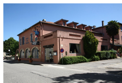
Fig. 12 - Avenue des Thermes, hôtel-restaurant (AX 446), vue depuis le nord-ouest.
