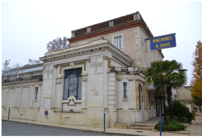
Fig. 10 - Partie nord, vue depuis l'est.
