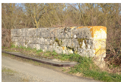
Fig. 4 - Castéra-Verduzan, La Boubée, pont (parcelle AS 302), parapet, vue depuis l'ouest.
