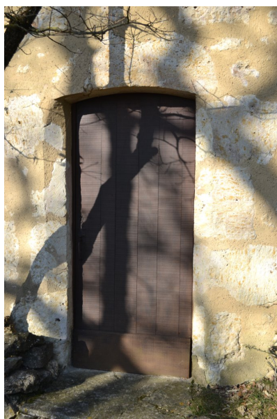
Fig. 5 - Moulin de Vernon, moulin à vent, détail de la porte, vue depuis le sud.
