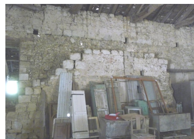
Fig. 3 - Vue du mur Nord de la grange (intérieur).
