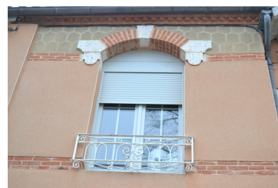
Fig. 3 - Façade ouest, détail de la fenêtre de l'étage.
