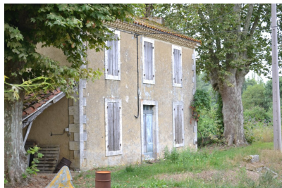
Fig. 2 - Bonas, Le Comté, maison éclésièrre (AK 10), élévation ouest, vue depuis le nord-ouest.
