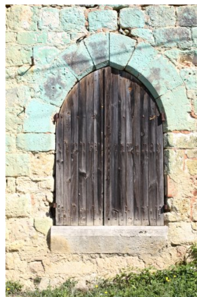
Fig. 9 - Maison (parcelle AS 22), façade sud, détail de la baie en arc brisé (avant travaux).
