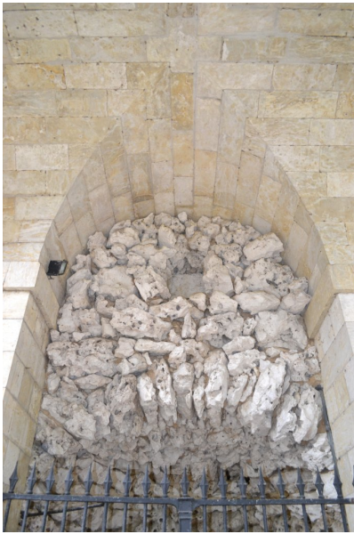
Fig. 10 - Façade nord, portique, fontaine orientale, détail de la rocaille.
