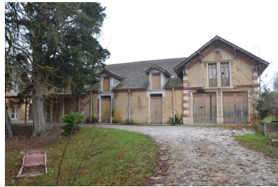
Fig. 11 - Communs, vue depuis le nord-est.
