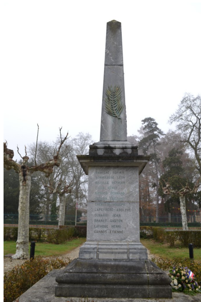
Fig. 11 - Vue latérale, vue depuis l'ouest.
