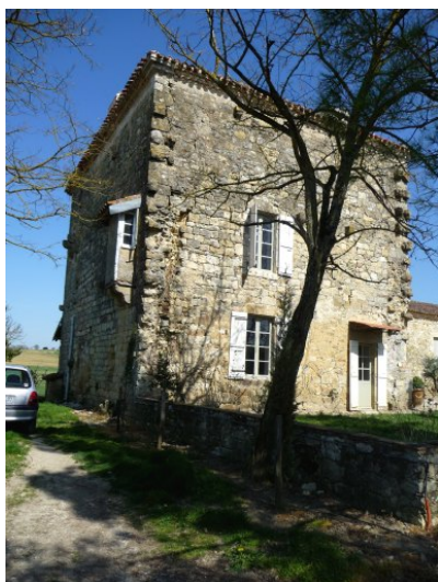
Fig. 1 - Vue de la tour prise du Sud.
