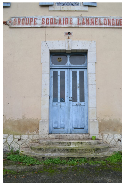
Fig. 3 - Façade nord, détail de la porte et de l'inscription.
