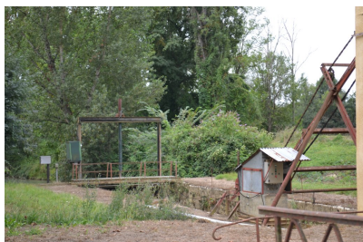
Fig. 7 - Bonas, Le Comté, écluse, vue depuis le nord-est.
