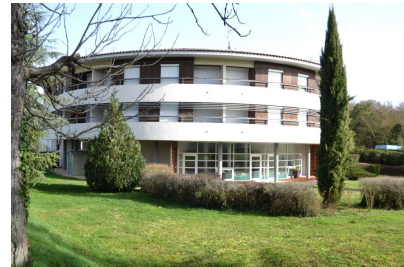
Fig. 21 - Partie récente, vue depuis le sud-ouest.
