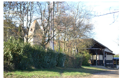
Fig. 18 - Jouaitard, vue d'ensemble depuis l'est.
