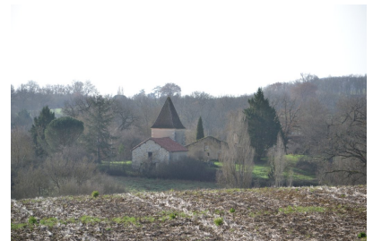
Fig. 30 - La Roumette, vue d'ensemble depuis le nord.
