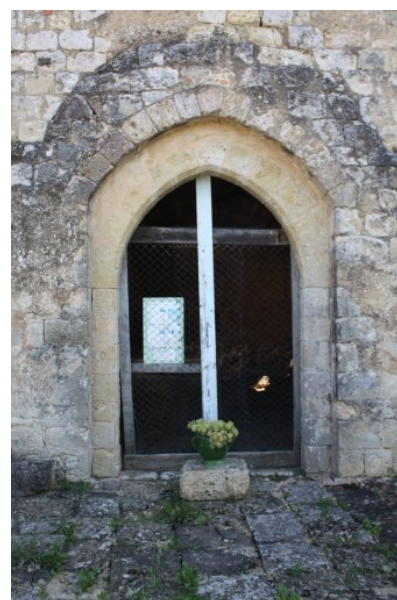
Fig. 6 - Façade occidentale, portail.
