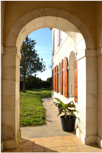
Fig. 10 - Corps de bâtiment principal, façade sud, portique, vue depuis l'est.
