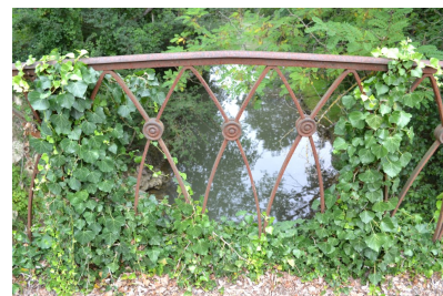
Fig. 9 - Bonas, Le Comté, pont, détail de la rambarde, vue depuis le sud.
