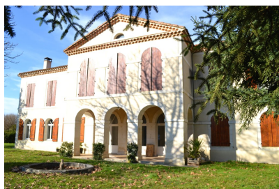
Fig. 2 - Corps de bâtiment principal, façade sud, vue depuis le sud-est.
