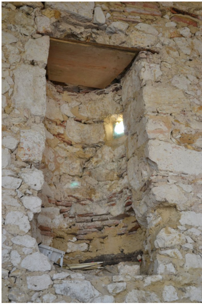
Fig. 43 - Corps de bâtiment secondaire, vue intérieure, citerne.
