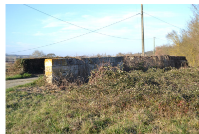
Fig. 3 - Castéra-Verduzan, La Boubée, pont (parcelle AS 302), vue depuis le sud-est.
