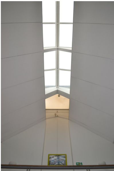
Fig. 46 - 1er étage, hall d'entrée, verrière.
