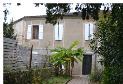
Fig. 12 - Avenue des Thermes, maison (parcelles AX 168), vue depuis le sud.
