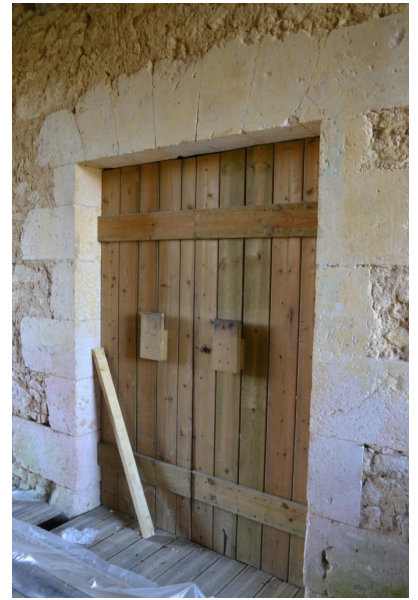
Fig. 27 - Porte sous la galerie, vue depuis le nord-ouest.
