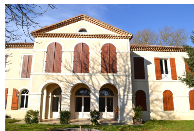
Fig. 3 - Corps de bâtiment principal, façade sud, vue depuis le sud.
