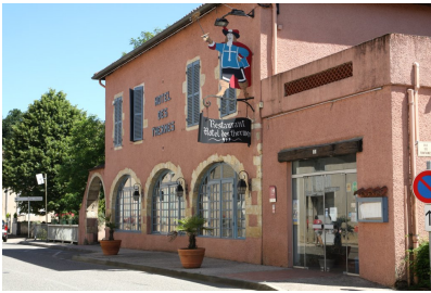
Fig. 13 - Avenue des Thermes, hôtel-restaurant (AX 446), vue depuis le nord-ouest.
