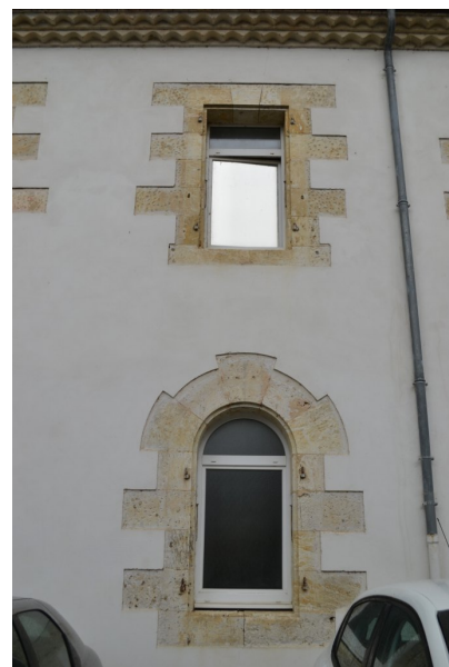
Fig. 27 - Elévation orientale, détail d'une travée, vue depuis l'est.
