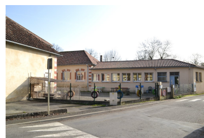
Fig. 9 - Extension, vue depuis l'ouest.
