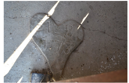
Fig. 57 - Ancienne hôtellerie, salle ouest, date portée gravée dans le béton "31 - 8 - 1973".
