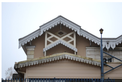
Fig. 22 - Elévation sud donnant sur le parc, détail des lambrequins.
