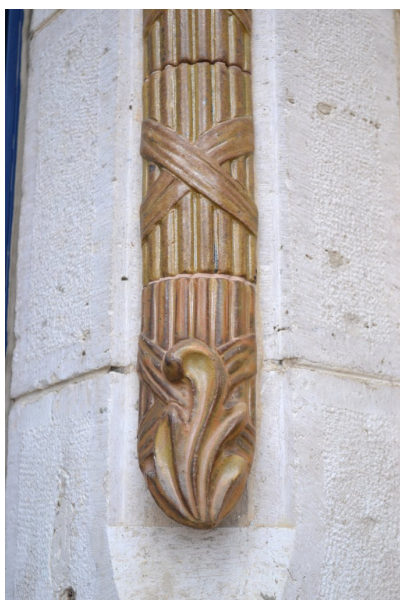
Fig. 7 - Façade nord, galerie du musée, détail du décor en terre cuite vernissée.
