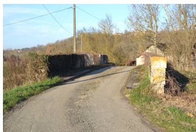
Fig. 2 - Castéra-Verduzan, La Boubée, pont (parcelle AS 302), vue depuis le sud.
