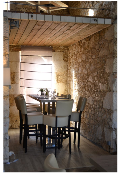
Fig. 39 - Aile intermédiaire, vue intérieure d'une ancienne cabine de bain, vue depuis l'est.
