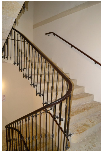
Fig. 32 - Escalier, vue depuis le palier du 1er étage.
