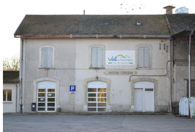
Fig. 2 - Gare de voyageurs, façade nord.
