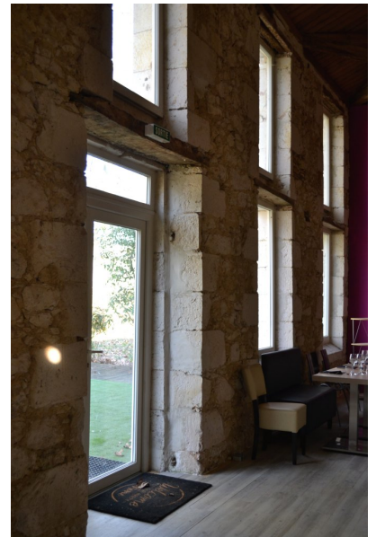
Fig. 42 - Corps de bâtiment secondaire, vue intérieure, vue depuis le sud-ouest.
