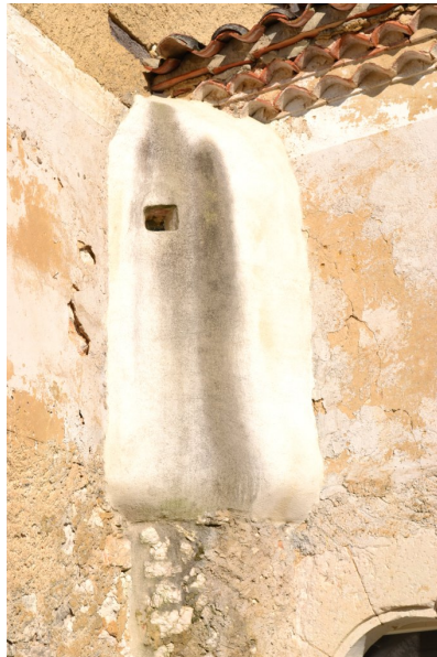
Fig. 23 - Citerne, vue extérieure, vue depuis le sud-ouest.
