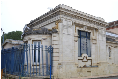
Fig. 19 - Elévation orientale, galerie du musée, partie sud, vue depuis le sud-est.
