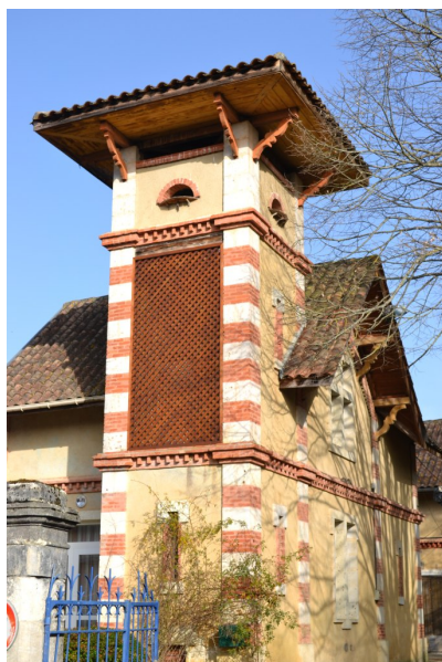
Fig. 2 - Maison de gardien, tourelle d'angle, vue depuis le sud-est.
