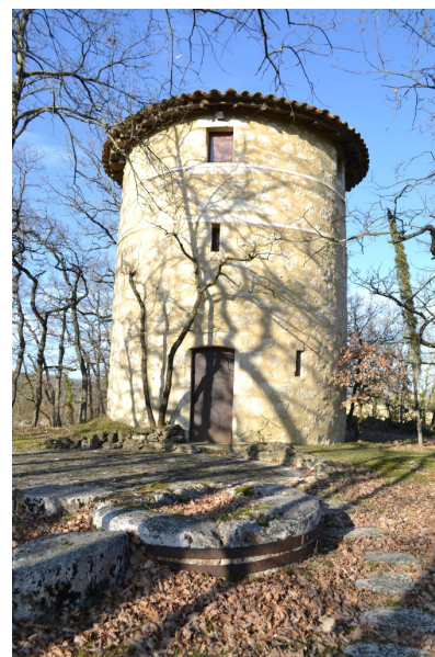
Fig. 3 - Moulin de Vernon, moulin à vent, vue depuis le sud.
