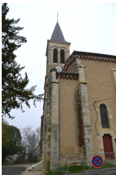
Fig. 5 - Clocher, vue depuis le sud.
