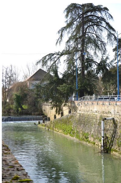
Fig. 2 - Canal principal, vue depuis le nord-est.
