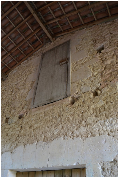
Fig. 28 - Porte sous la galerie, vue depuis le nord-ouest.
