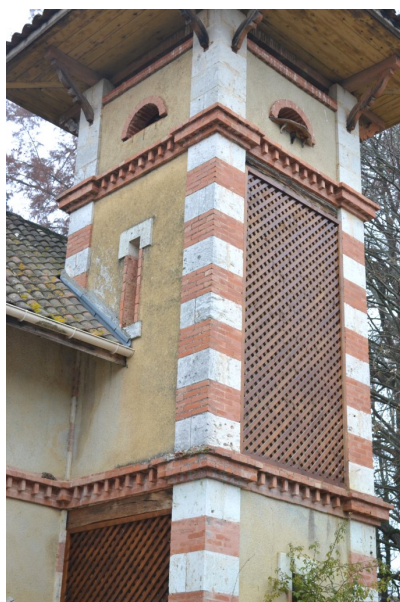
Fig. 5 - Maison de gardien, tourelle d'angle, vue depuis le sud-ouest.
