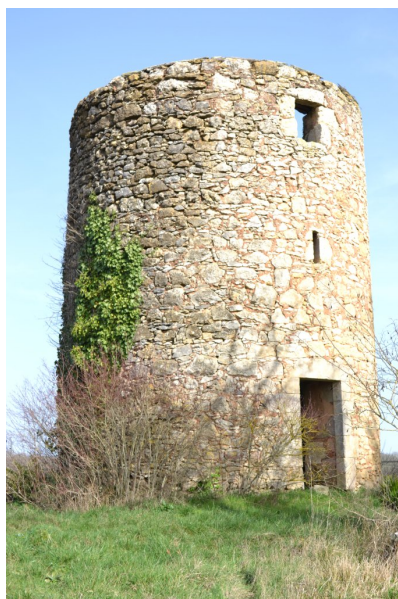
Fig. 2 - Jouaitard, moulin à vent, vue depuis le sud-ouest.
