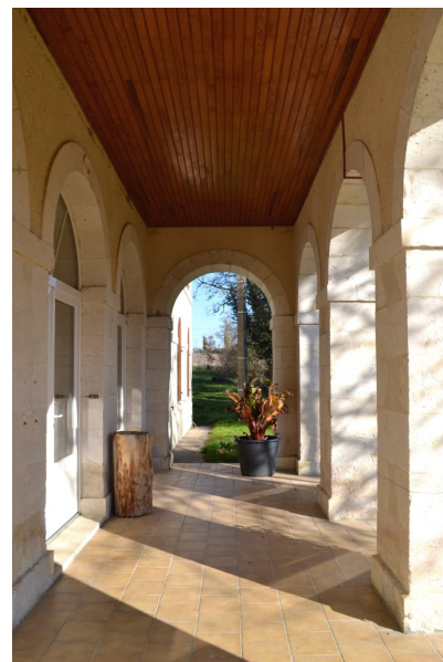
Fig. 6 - Corps de bâtiment principal, façade sud, portique, vue depuis l'ouest.
