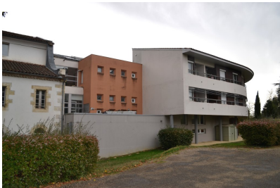
Fig. 19 - Partie récente, vue depuis le nord-ouest.
