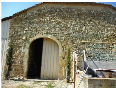
Fig. 1 - Vue du mur Est de la grange.
