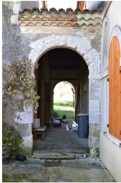
Fig. 26 - Galerie, vue depuis l'ouest.
