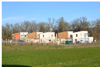
Fig. 23 - Lotissement vers le Château, vue depuis le sud.
