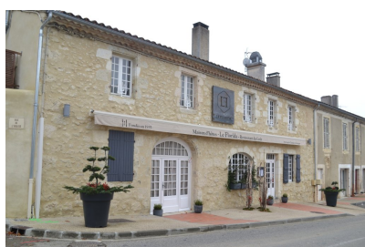
Fig. 11 - Rue du Lac, maison d'hôtes et restaurant (AX 69), vue depuis le nord-ouest.
