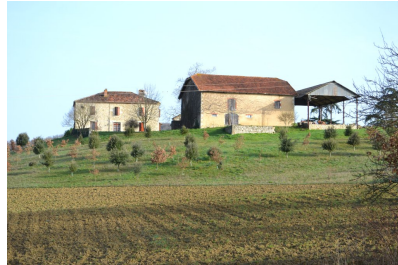
Fig. 14 - Guillauma, vue d'ensemble depuis le sud.
