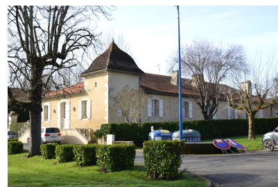
Fig. 3 - Vue depuis le nord-est.
