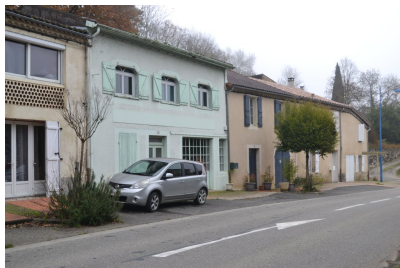
Fig. 1 - Avenue Claude Bordenave, maisons (parcelles AX 91, 488, 93), vue depuis le nord-ouest.
