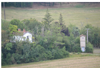
Fig. 1 - Bonas, Laressource, maison de garde-barrière (AN 4) et transformateur (AC 108), vue depuis le nord.
