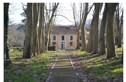
Fig. 18 - Corps de bâtiment secondaire, vue d'ensemble depuis le nord.
