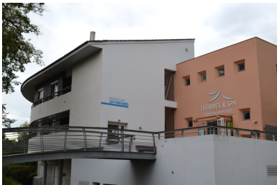
Fig. 22 - Partie récente, vue depuis le nord-est.
