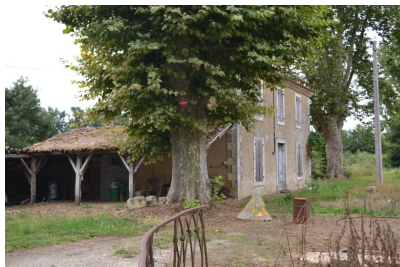
Fig. 1 - Bonas, Le Comté, maison éclésièrre (AK 10), vue depuis le nord-ouest.
