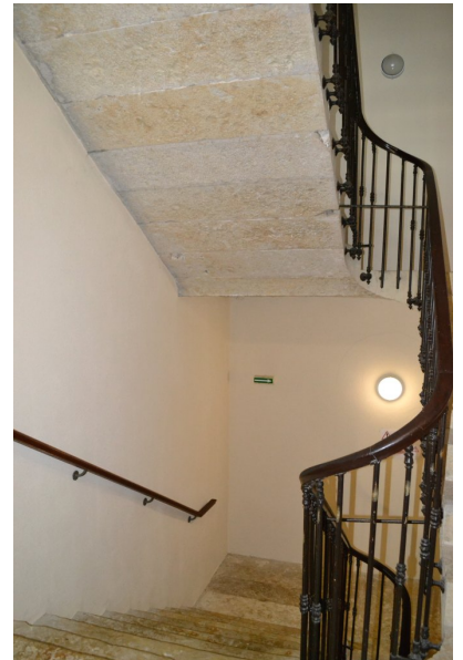
Fig. 33 - Escalier, vue depuis le palier du 1er étage.
