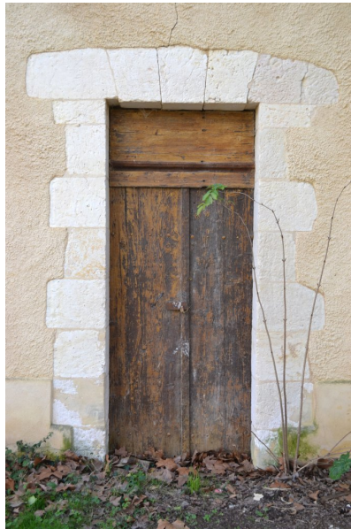
Fig. 53 - Ancienne hôtellerie, élévation nord, détail de la porte.
