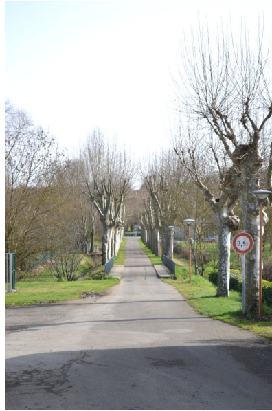
Fig. 17 - Promenade de l'Auloue, allée et pont, vue depuis l'ouest.
