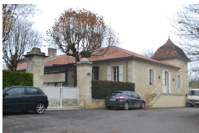
Fig. 1 - Vue depuis le sud-est.
