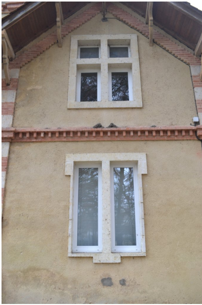
Fig. 7 - Maison de gardien, élévation orientale, détail des baies.
