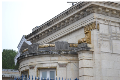
Fig. 20 - Elévation orientale, galerie du musée, partie sud, détail, vue depuis le sud-est.
