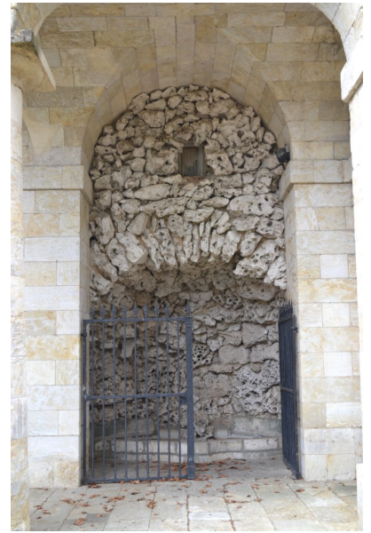
Fig. 12 - Façade nord, portique, fontaine occidentale.
