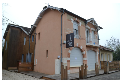
Fig. 2 - Vue depuis le nord-ouest.
