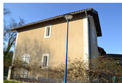
Fig. 9 - Castéra-Verduzan, Pouchon, maison de garde-barrière (parcelle AW 61), vue depuis le sud-est.
