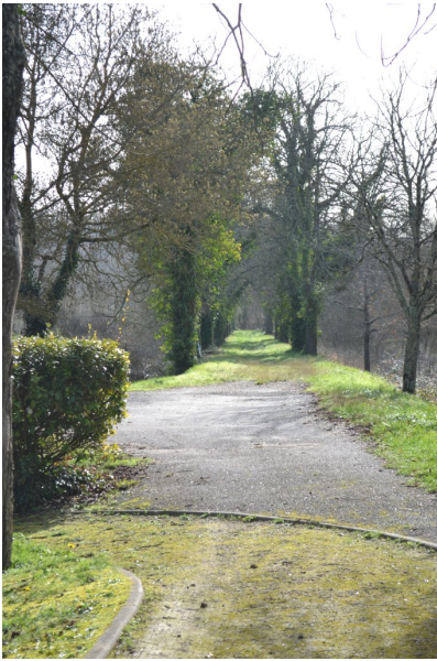
Fig. 7 - Digue au sud des thermes, vue depuis le nord.
