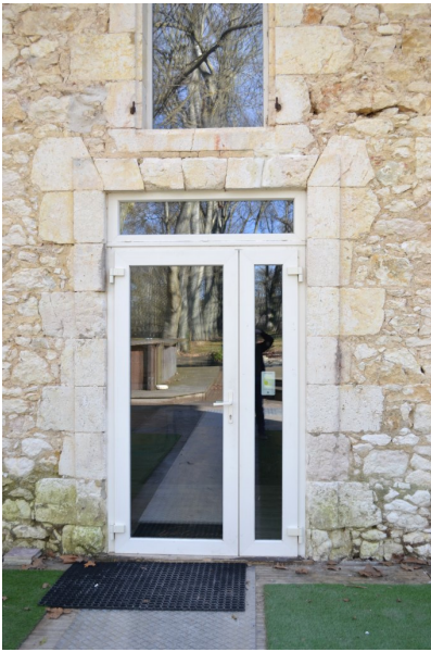
Fig. 19 - Corps de bâtiment secondaire, porte d'entrée.
