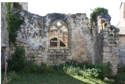
Fig. 10 - Chapelle nord, vue depuis le nord (avant travaux).
