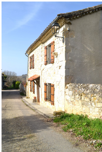
Fig. 14 - Maison (parcelle AS 26), vue depuis le sud-est.
