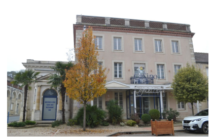
Fig. 27 - Ancienne villa Lannelongue, façade nord.
