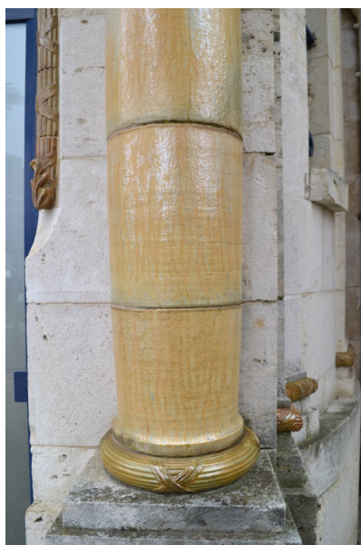
Fig. 5 - Façade nord, galerie du musée, détail du décor en terre cuite vernissée.
