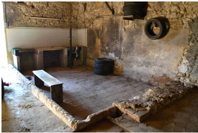
Fig. 55 - Ancienne hôtellerie, vue intérieure, salle ouest, ancien pressoir, vue depuis le nord-est.
