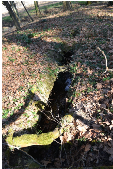
Fig. 68 - Parc, anciennes canalisations.
