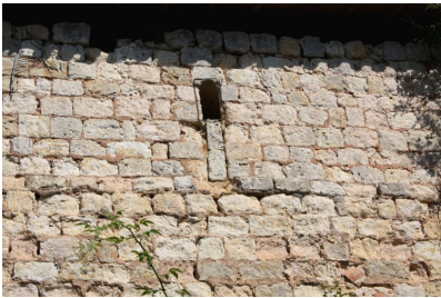
Fig. 19 - Mur sud, détail d'un jour.
