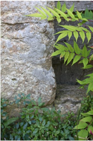
Fig. 16 - Mur nord de la nef, porte, détail du congé du piédroit gauche.
