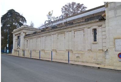
Fig. 16 - Elévation orientale, galerie du musée, vue depuis le nord-est.
