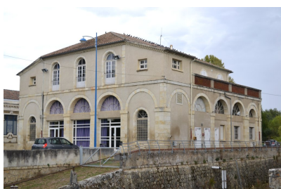
Fig. 7 - Vue d'ensemble depuis le sud-est.
