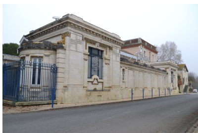
Fig. 1 - Vue d'ensemble depuis le sud-est.
